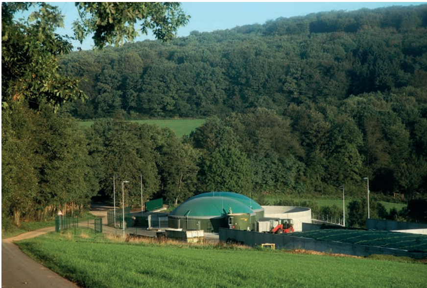
Die Biogasanlage des Wendelinushofs
